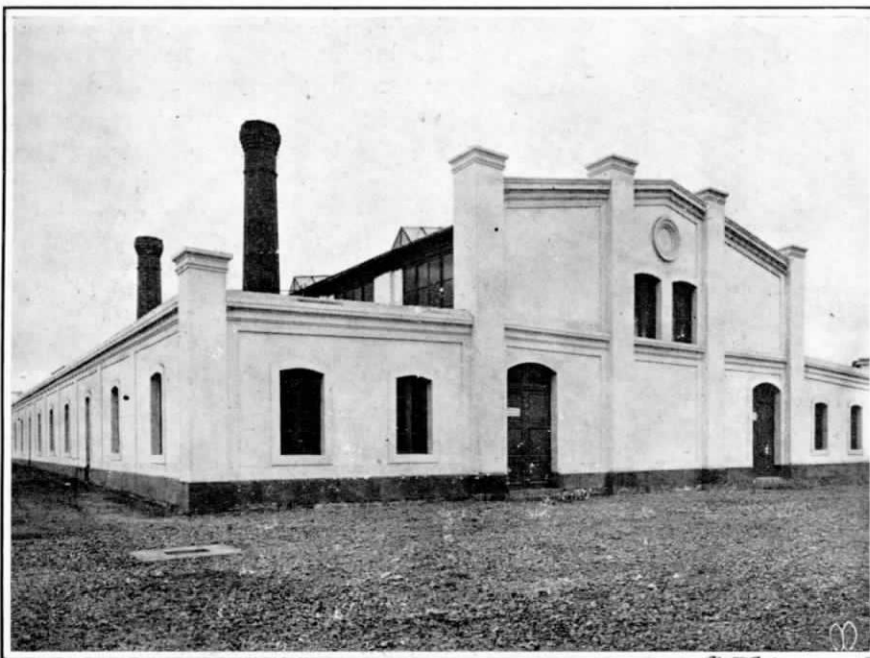
Fachada de la Sala de Máquinas
